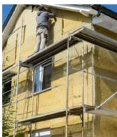
Travaux d'isolation © Illustration I.A.
